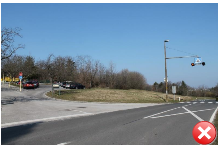
Slika 9: Nevaren odsek brez pločnika iz smeri Skopo.
